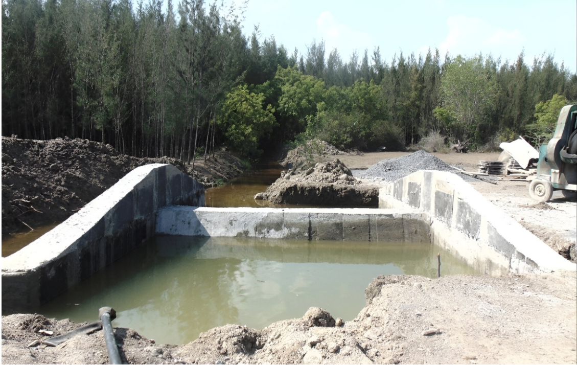
மாவட்ட கனிம அறக்கட்டளை நிதியின் கீழ் விழுப்புரம் மாவட்டம் வானூர் தாலுகா பொன்னம் பூண்டி கிராமத்தில் பொன்னம் பூண்டி சப்ளை கால்வாயின் குறுக்கே தடுப்பணை கட்டுதல்.
